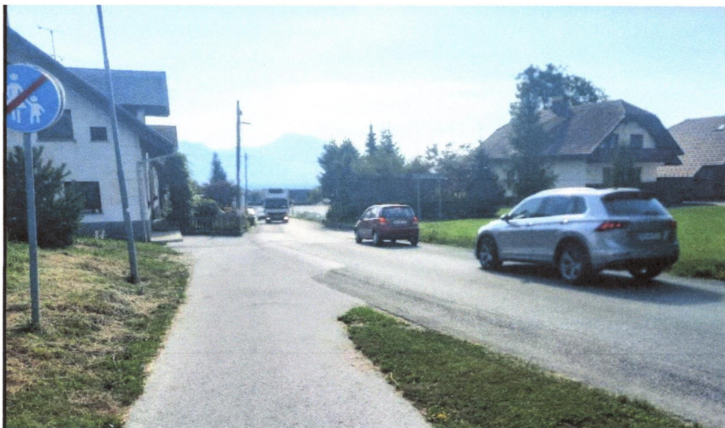
Slika 3: REGIONALNA DRŽAVNA CESTA BLED–POKLIJKA V SP. GORJAH, kjer se steza za pešce konča za nepreglednim ovinkom, brez prehoda za pešce
