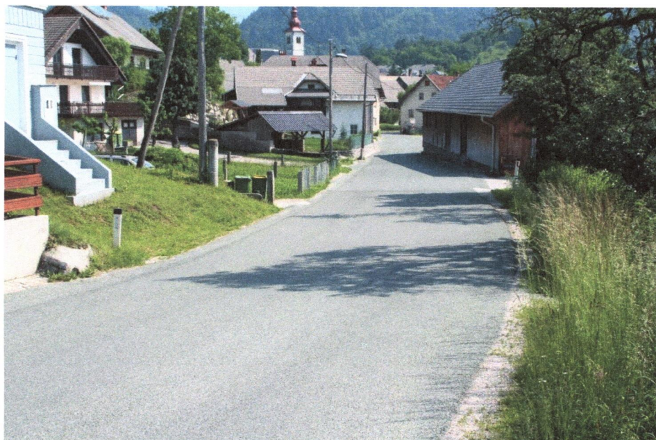
Slika 2: REGIONALNA DRŽAVNA CESTA BLED - POKLJUKA, OD KMETIJE "REPEČNIK" DO "PEKOVE HIŠE" ni varnih površin za pešce
