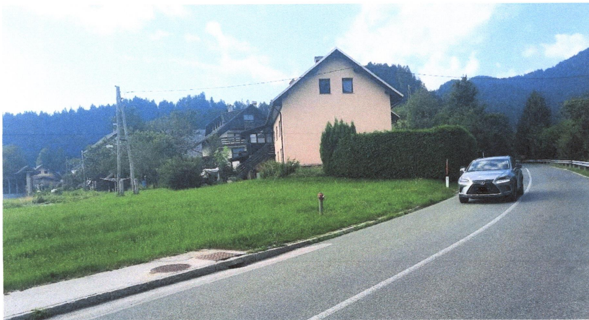
Slika 5: REGIONALNA DRŽAVNA CESTA BLED–POKLJUKA V KRNICI, kjer se pločnik konča za slabo preglednim ovinkom, brez prehoda za pešce
